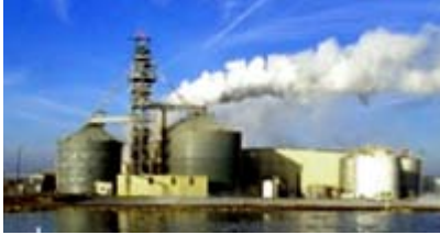
Planta Abengoa en Colwich, EUA. Foto: Abengoa.
