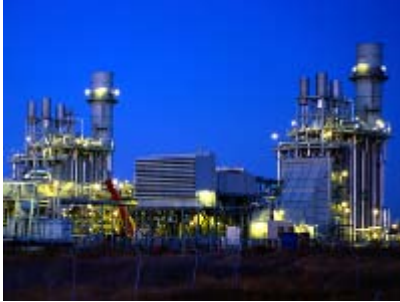
Planta Calpine en Los Médanos. Foto: Calpine.
